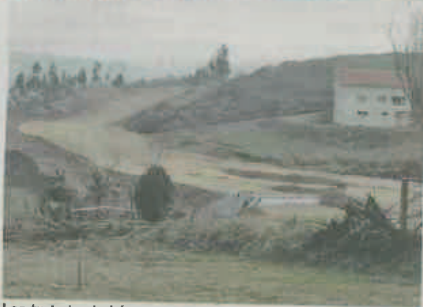
Los trabajos habían comenzado en mayo. A. BALLESTEROS
